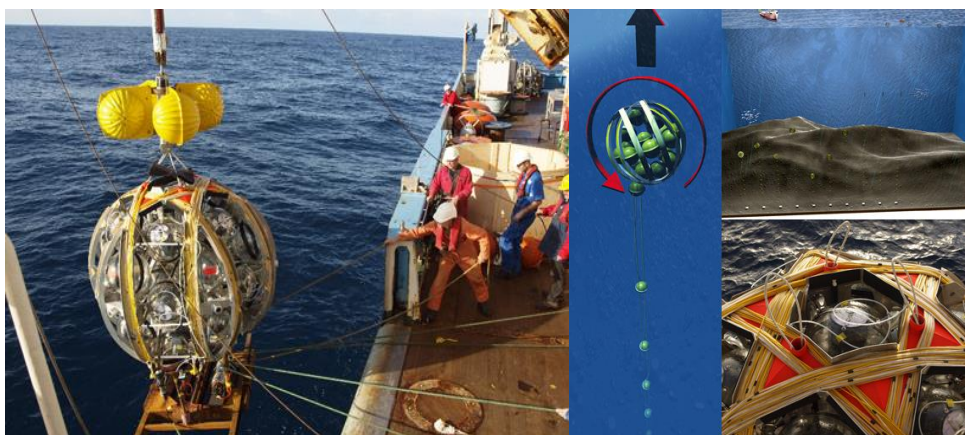
Рисунок 1-9 – методика развертывания гирлянды KM3Net в Средиземном море
